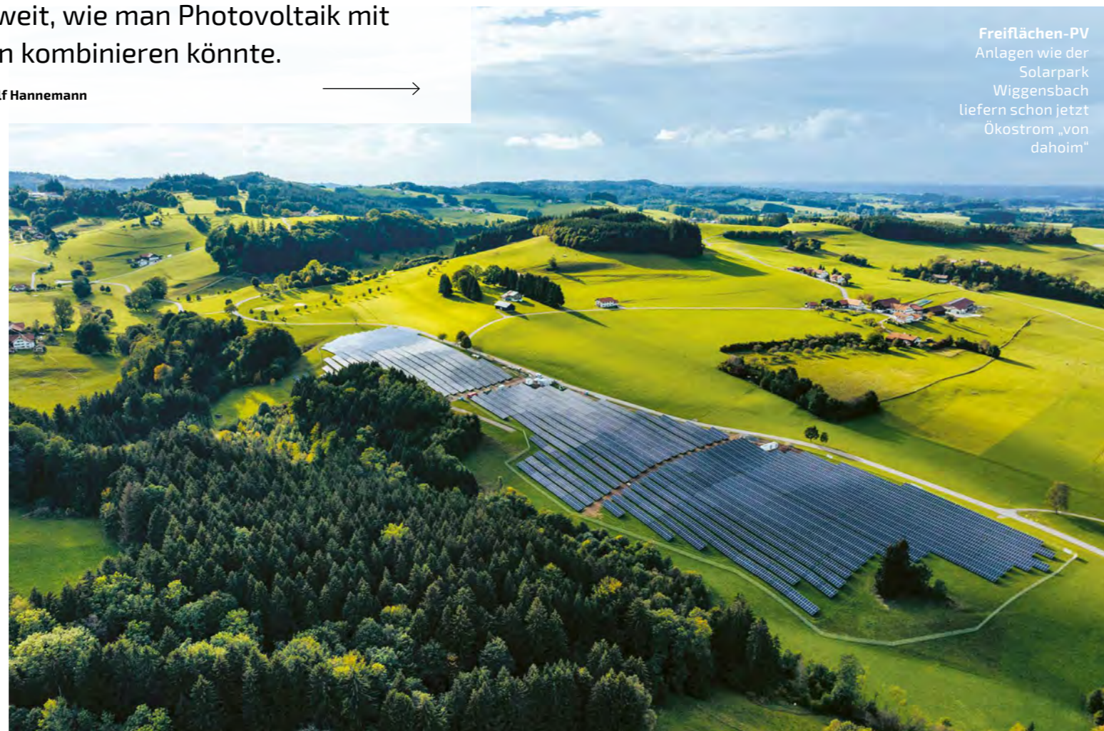
Autobahn-Überdachung An der A81 vor Singen testen Forscher Solarmodule über der Fahrbahn
